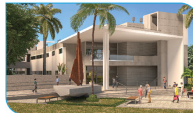
Modernización comprensiva de los edificios Ferré y Aguayo y construcción edificio de Laboratorios de Ciencias
